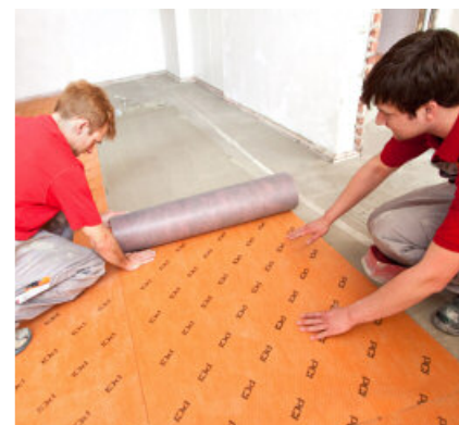
Keramiek kan op de afdichtings- en ontkoppelingsmat PCI Pecilastic U eenvoudig aangebracht worden.
